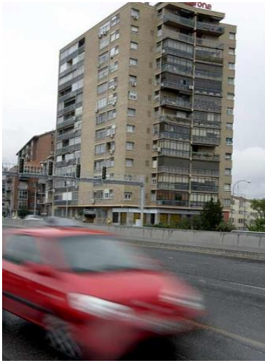
Edificios afectados por el ruido en la avenida de Portugal- RICARDO GUTIÉRREZ
