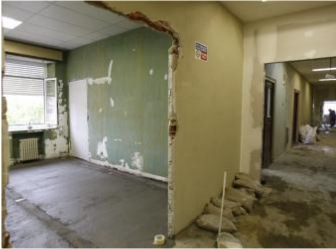
Los obreros trabajaban ayer en las obras- CRISTOBAL MANUEL
