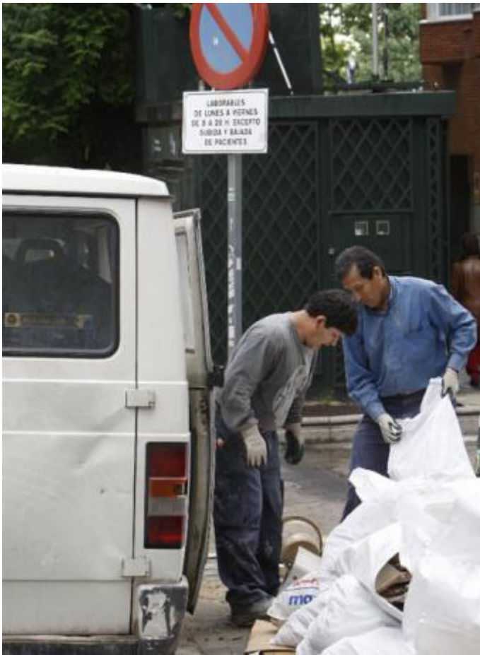
Dos operarios cargan sacos de escombros-
