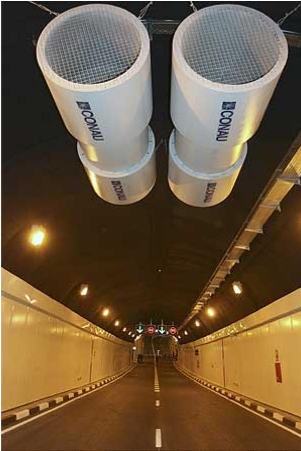
Obras. M-30. Sistema de ventilación. (FOTO: Carlos Miralles)
