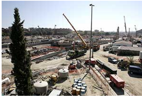
Obras de la M-30 en Marqués de Vadillo. (Foto: Jaime Villanueva).
