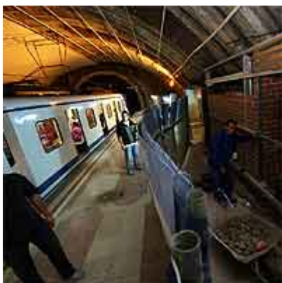
Una endeble valla separa a los pasajeros del metro de los operarios (uno de ellos sin casco) de las obras de reforma de Legazpi. (SANTI BURGOS)
