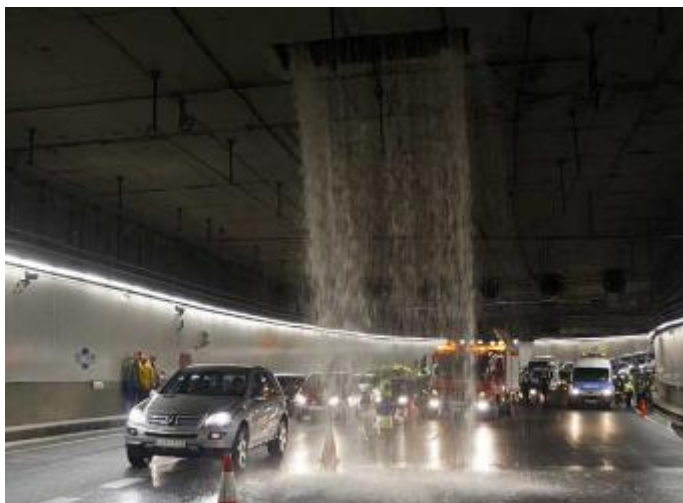
Túnel inundado en la M-30- CLAUDIO ÁLVAREZ
