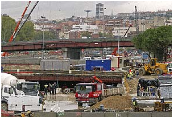
Imagen de las obras de la M-30. (Foto: J. Palomar)
