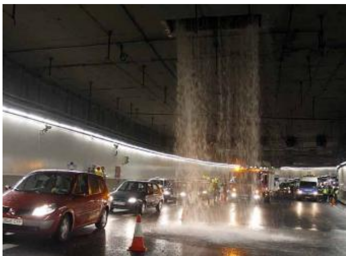
Cascada de agua en un túnel de la M-30- CLAUDIO ÁLVAREZ
