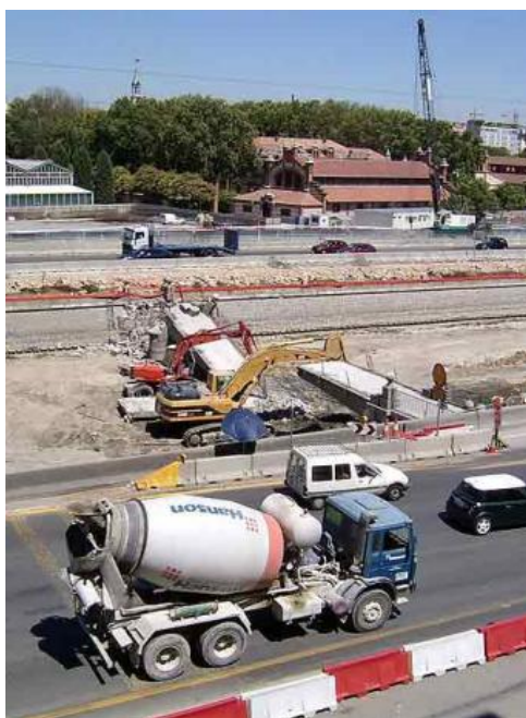
Una excavadora derriba un puente sobre el Manzanares
