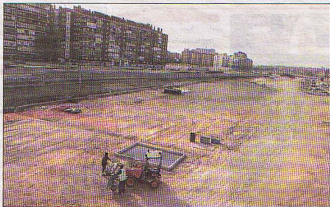
Obras en el distrito de Arganzuela, en las cercanías del Matadero
