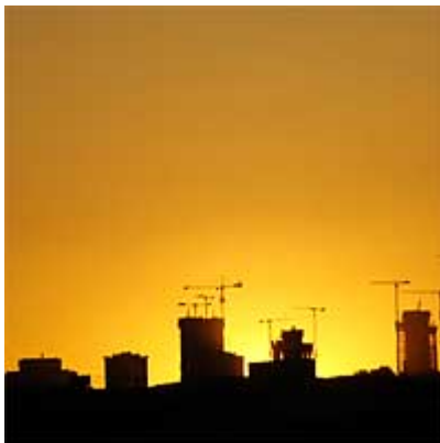
Silueta de Madrid al atardecer, con las cuatro torres en construcción del paseo de la Castellana. (CLAUDIO ÁLVAREZ)
