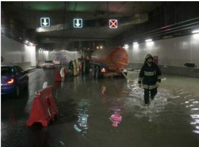
Túnel de la M-30 inundado- CLAUDIO ÁLVAREZ
