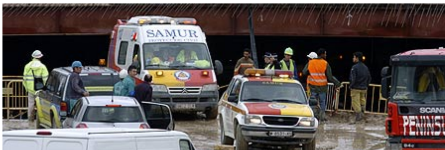
El accidente ocurrió en un túnel de las obras de la M-30, a la altura del Puente de Segovia (EFE/ J.L PINO)
