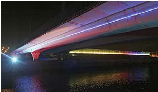
Otra imagen de la iluminación. (Foto: Julián Jaén)
