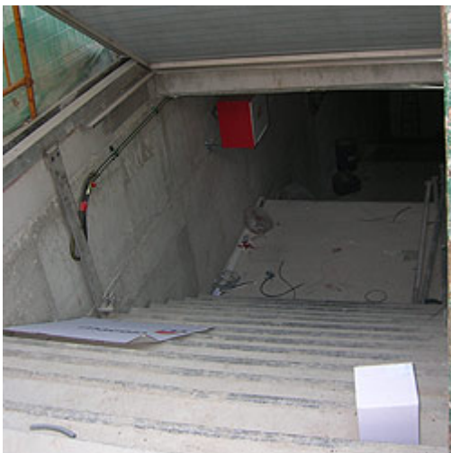
Salida complicada en el túnel de San Dámaso (Juan José Fuentetaja )
