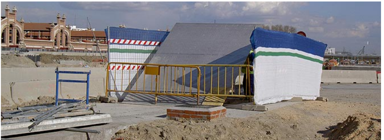
Salida del túnel de la M-30. (Foto enviada por el autor del post)
