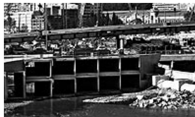
Una de las zonas que han sido causa de polémica de las obras. / CARLOS MIRALLES
