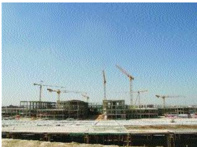
El futuro Hospital de Vallecas es uno de los ejemplos, según los vecinos, de "mala planificación". (Foto: Comunidad de Madrid)
