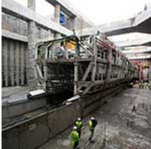
La tuneladora Dulcinea excavará el túnel sur en las obras de soterramiento de la M-30. (SANTI BURGOS)
