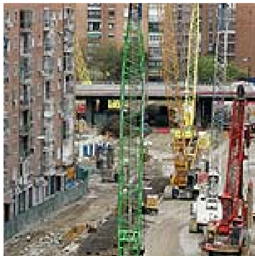
Algunas de las grúas que trabajan en las obras de la M-30. (ULY MARTÍN)
