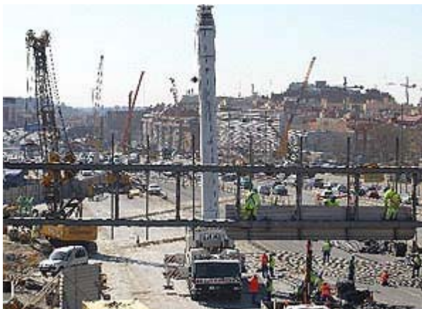
Imagen de las obras de la M-30. (EL MUNDO)
