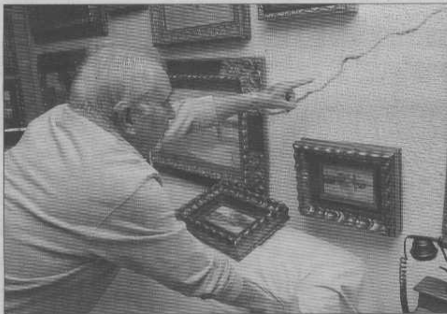
Uno de los vecinos afectados señala las grietas aparecidas en su pared.
