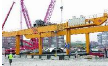
La segunda tuneladora del 'by-pass' sur ya ha llegado al distrito de Arganzuela, junto al invernadero.
