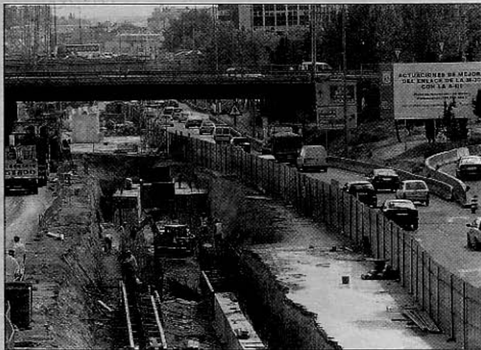
Las obras de remodelación de la M-30 cuentan con un presupuesto total de 4.000 millones de euros.
