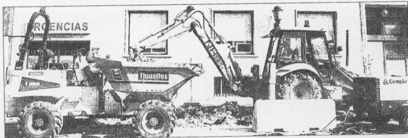
Las obras de la M-30 tapan la entrada al ambulatorio de la Avenida de Portugal. (FACCO TOLEDO)
