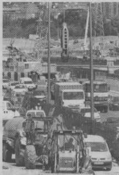
Obras de la M-30
