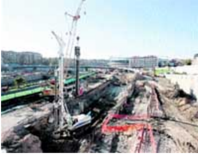
En el Manzanares. Así estaban ayer las obras de reforma de la M-30 en el cauce del río.
