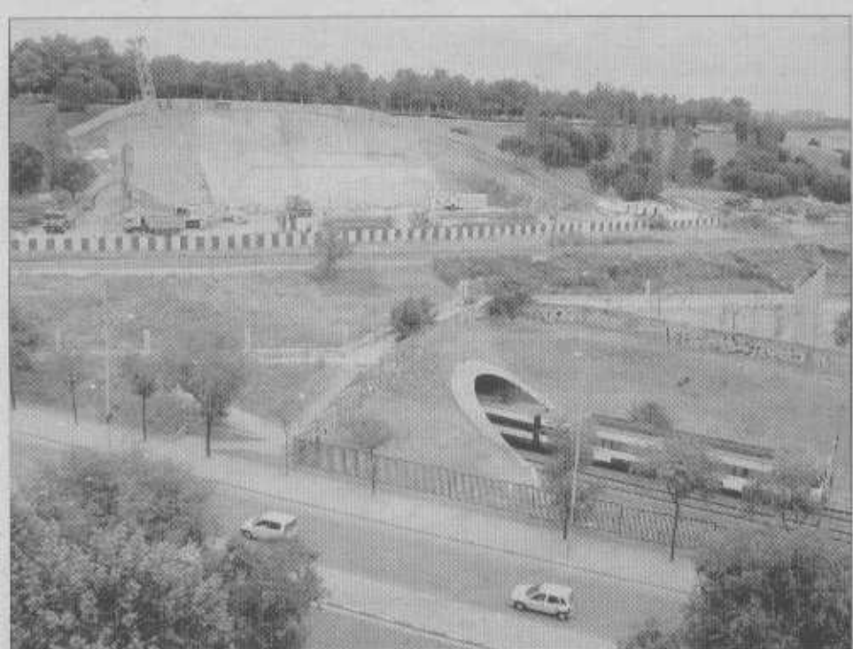
Obras del nuevo túnel de la M-30 bajo el parque Tierno Galván para evitar el nudo sur.
